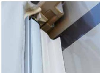
Les profilés du mât sont fixés avec des joints en caoutchouc pour éviter les rayures et pour rendre la zone entièrement étanche. La hauteur se règle facilement.
